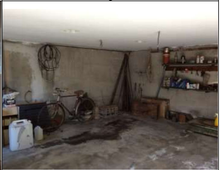
Foto 24: P-1 (sub 5) Garage
