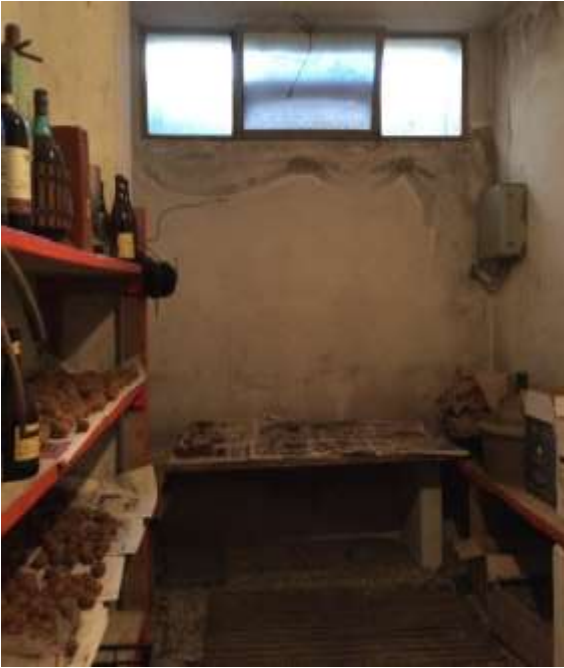
Foto 13: abitazione n.1 (sub 3) – P-1 Cantina
