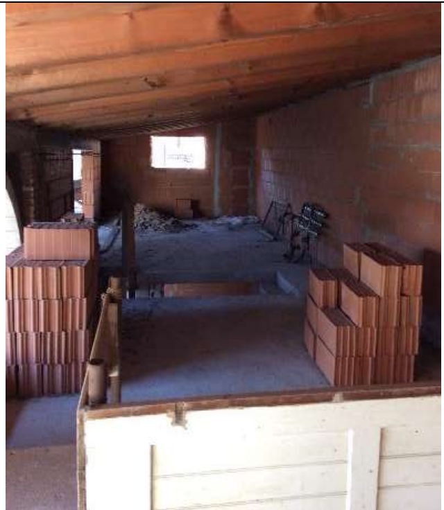
Foto 28: Magazzini (sub 6) PT e P1 – fabbricato posto sul retro edificio abitazioni
